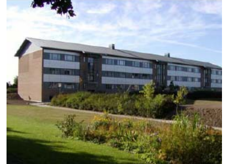
Bjergbakken som afdelingen fremstår efter renoveringen.
