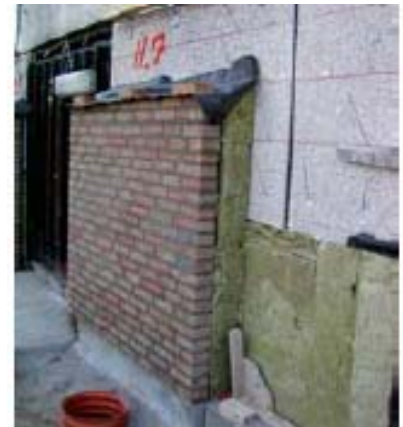
De nye teglstensydere - hulrummet mellem murene isoleres godt.
